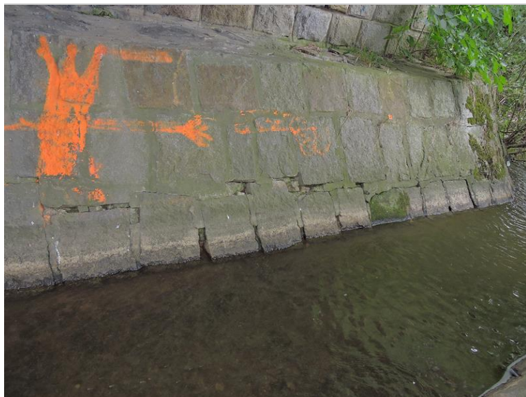
Vypadané spárování v opevnění koryta před OP2
