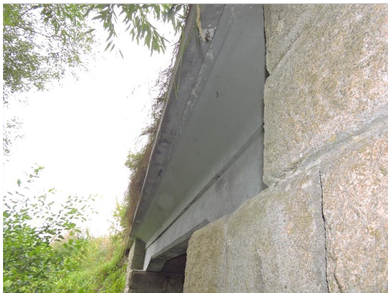
Levá mostní římsa - zatékání
