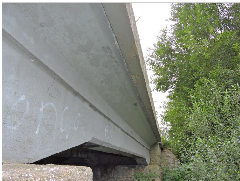
Pravá mostní řimsa - odhalená výztuž, zatékání. Nad křídlem č. 2 na pravé straně je řimsa zcela odlomená.
