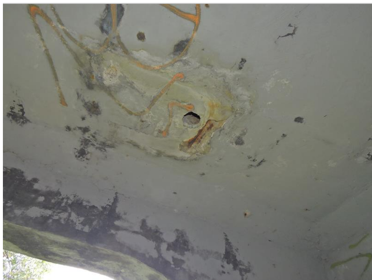
Zatékání okolo odvodňovače, výluhy, opadaná krycí vrstva, zkorodovaná výztuž.
